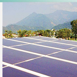
高雄市立龍興小學 組合式屋頂 竣工:2011年 建築面積: 75平方公尺
